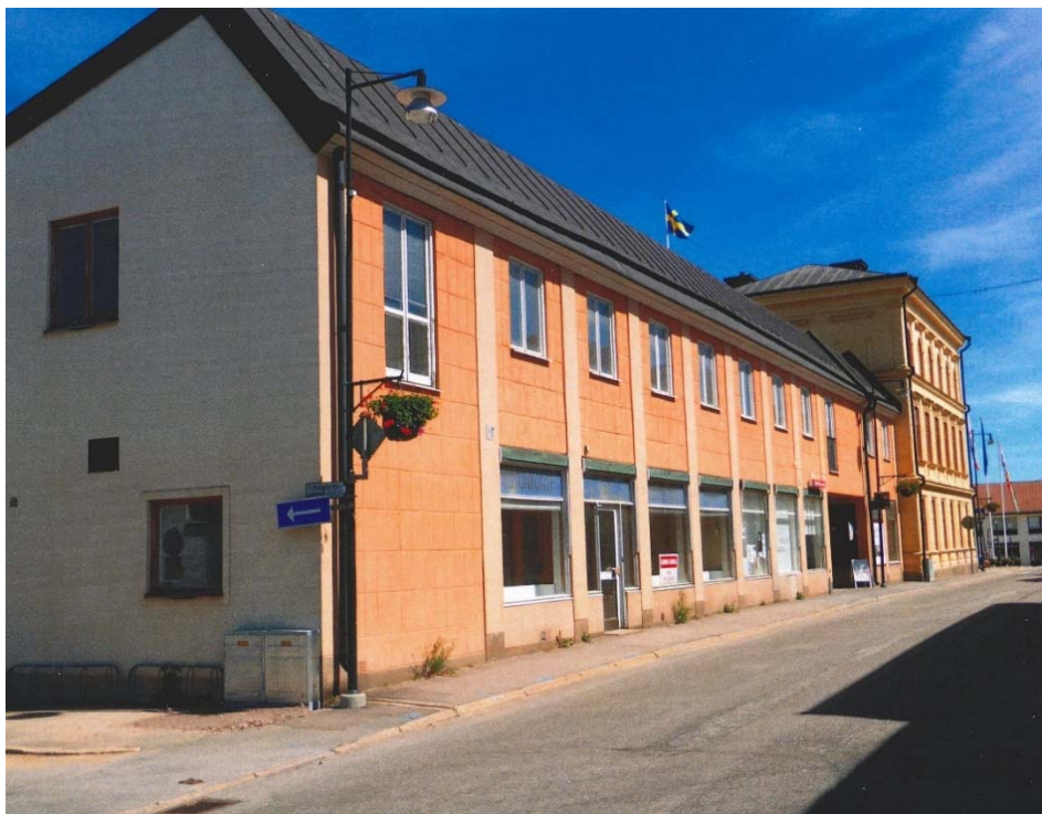
Bilden tagen före ombyggnation
